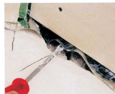
Soll der Anschluss der Luftdichtheitsschicht auf dem Putz erfolgen, müssen Putz und Folie ausreichend überlappen. Der Anschluss kann anschließend hinter der Innenbekleidung verschwinden. In diesem Fall müsste nachgearbeitet werden – mit erheblichen Verzögerungen im Bauablauf und zusätzlichen Kosten.
