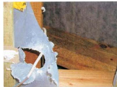
Oft wird eine bereits fachgerecht erstellte Luftdichtheitsschicht durch nachfolgende Gewerke beschädigt. Bei dieser „Elektroinstallation“ wurde die Folie für die Kabeldurchführung der Einfachheit halber perforiert. Dabei wurde auch der umgebende Bereich in Mitleidenschaft gezogen.
