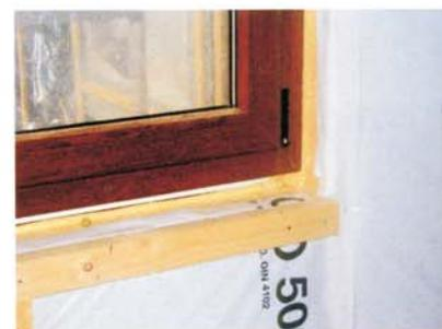
Ein Problem für die luftdichte Gebäudehülle im Bereich der Fassade sind die Fenster. Fachgerecht ist der Anschluss mittels einer Anschlussschürze oder die Folie wird auf den Rahmen geführt. Der hier eingesetzte Montageschaum allein ist für einen luftdichten Anschluss nicht geeignet.
