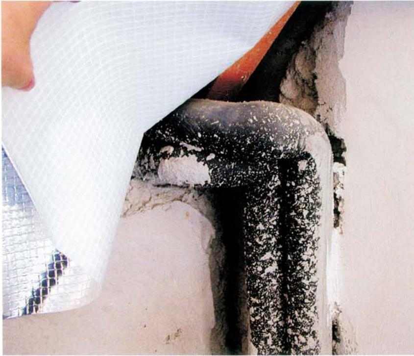
Fehlt eine fachgerechte Planung, führt dies auch bei sorgfältigster Ausführung oft nicht zu einem zufrieden stellenden Ergebnis. Bei dieser Rohrdurchführung ist ein luftdichter Anschluss nur noch mit zusätzlichem Aufwand möglich – z.B. durch eine Rohrverkleidung, an die die Luft- und Dampfsperre dann angeschlossen werden kann.
