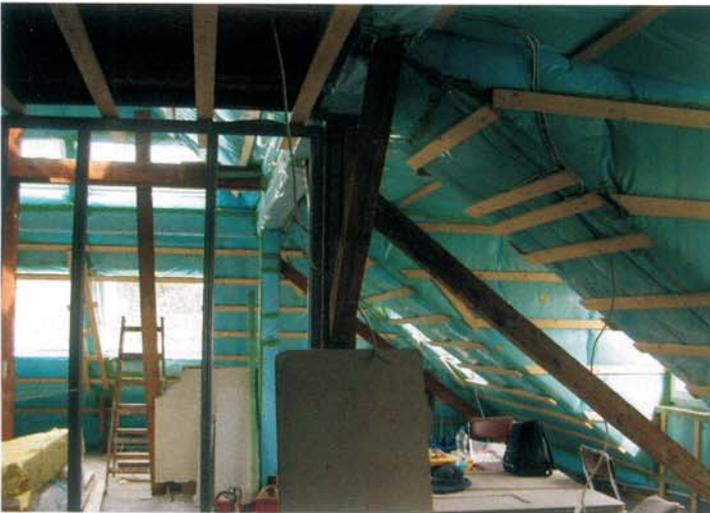
■ Die luftdichte Ebene ist noch sichtbar (Folie und Holzbauplatte): Der optimale Zeitpunkt für eine BlowerDoor-Messung.
