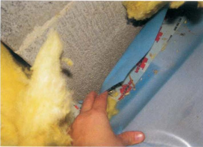
■ Leckage durch nicht fachgerecht ausgeführte Luftdichtung an einem Schornsteinanschluss.
